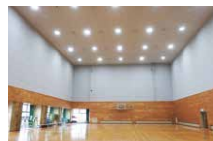
メインアリーナ 常時使用する灯具のみをLED化（左右がSE280）
