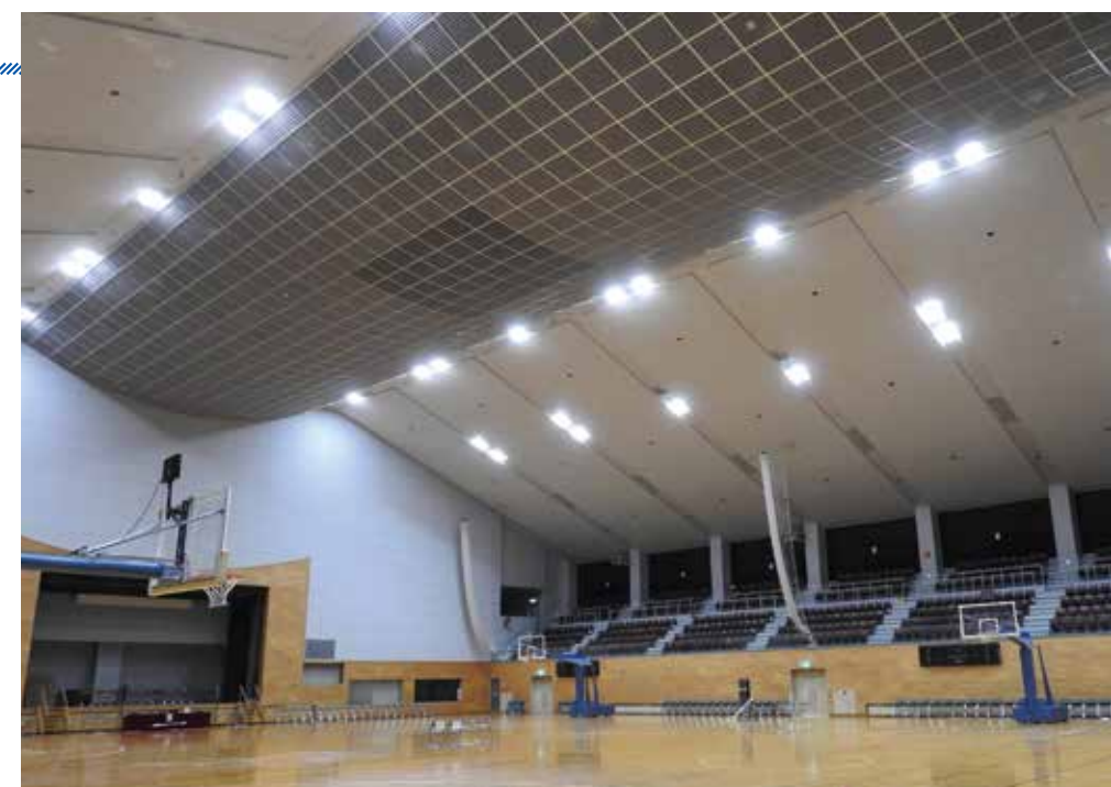
メインアリーナ 常時使用する灯具のみをLED化（左右がSE280）
