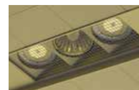
メインアリーナ 常時使用する灯具のみをLED化（左右がSE280）
