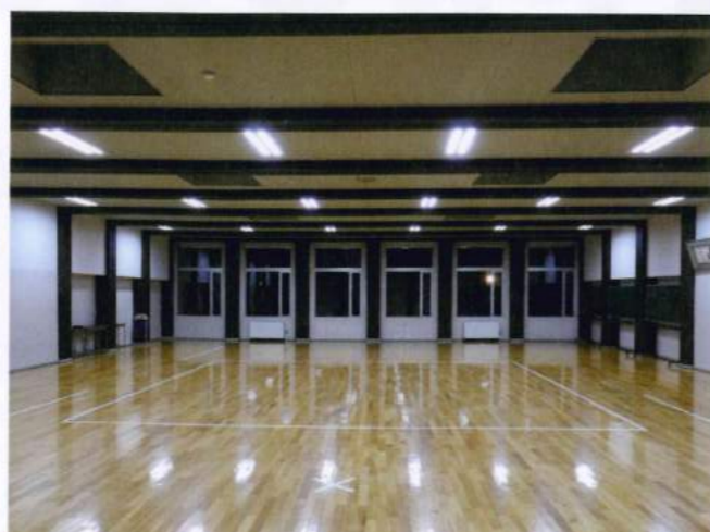
40W x 2灯の蛍光灯が28W LED照明に交換された剣道場
