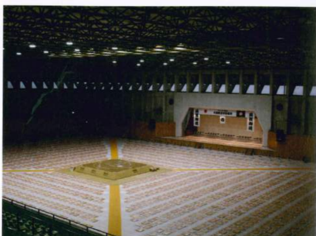
主に土俵周りを重点的に照らすパターンにも瞬時に切り換え可能。瞬間点灯、再点灯可能なLED照明の特長を活かしたライティングだ。
